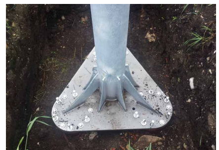
Säulenfundament mit 3 Spinnanker für 420kN
