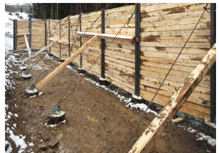
Verankerung einer Stützmauer Hochseilklettergarten
